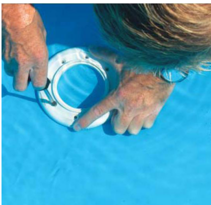
Pričvršćivanje priрубnice podnog ispusta
