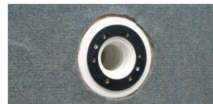
Precizno izrežiti filc oštrom nožem
