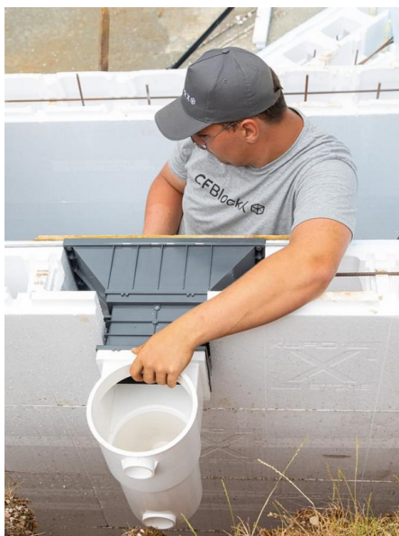
Postavljanje skimera u blokove
