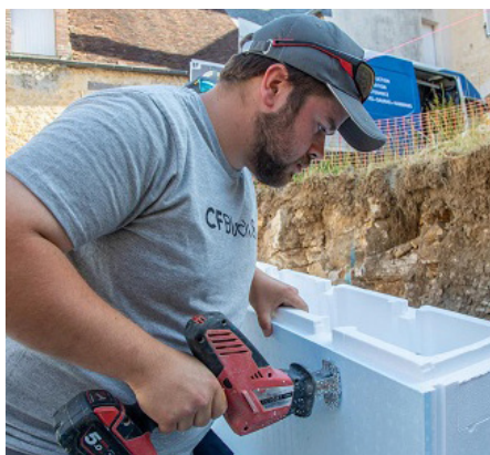
Priprema za izrez i montažu zida bazena
