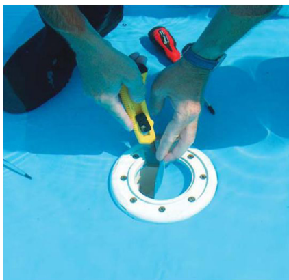
Izrezivanje folije nakon montaže priрубnice
