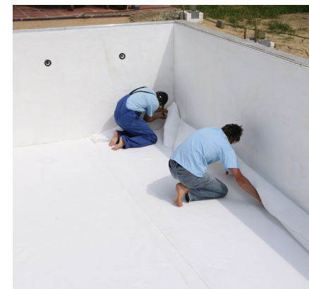
Ne preklapati filc na spojevima
