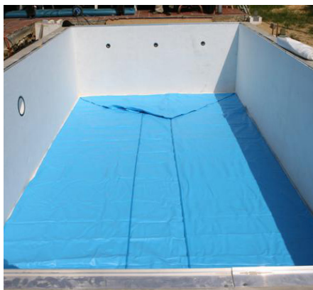
Postavljanje folije na dno bazena
