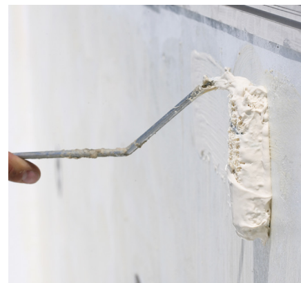
Filc se lijepi posebnim ljepilom
