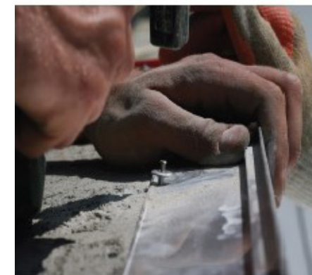
Pričvršćivanje profila zakucavanjem - zakovicama
