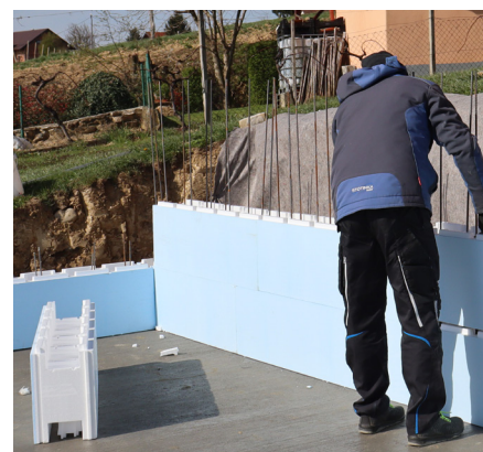
Postavljanje stiropornih blokova
