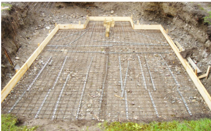
Montiranje i armiranje ploče
