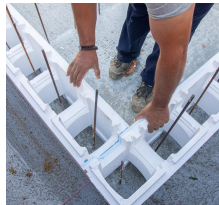
Postavljanje prvog reda stiropornih blokova
