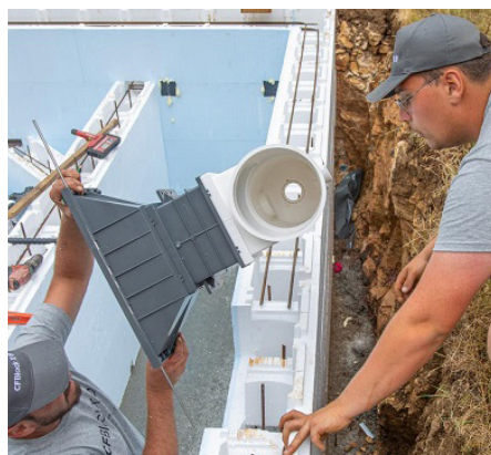
Montaža ugradbenog elementa prije zalijevanja ugradbenog elementa u zid bazena betonom
