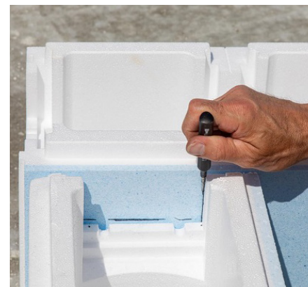
U svakom redu na sva 4 kuta se izreže otvor gdje su armature spojene i ispunjene betonom
